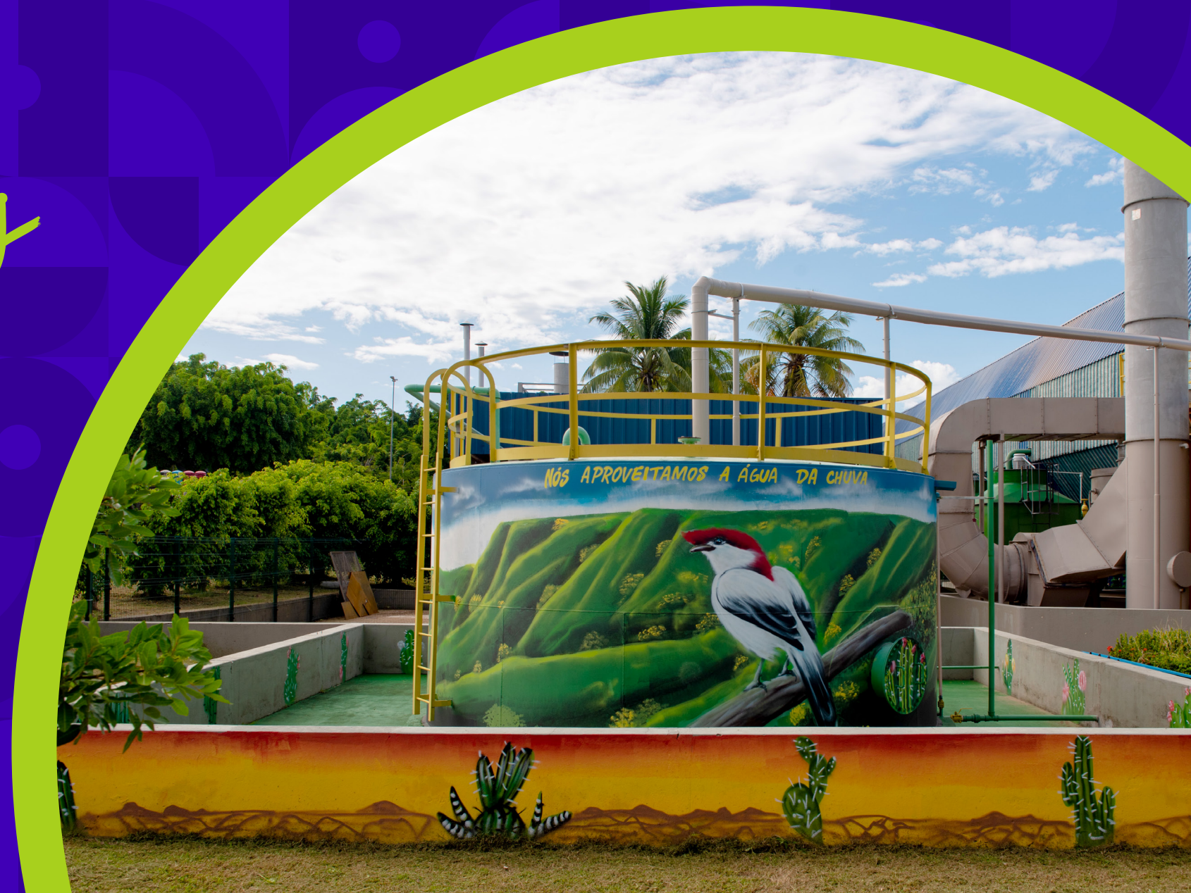
Tanque de captación del agua de lluvia - Unidad Crato (CE)
